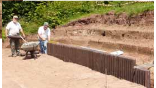
Die erste Reihe der Hohlkehlpalisaden wird gesetzt.
