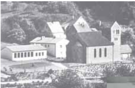
Das Jugendheim (links im Bild) im fertigen Rohbau (1964).
