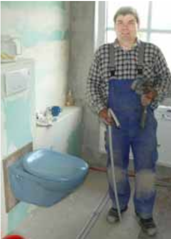
Arno Becker beim Einbau der provisorischen Toilette.
